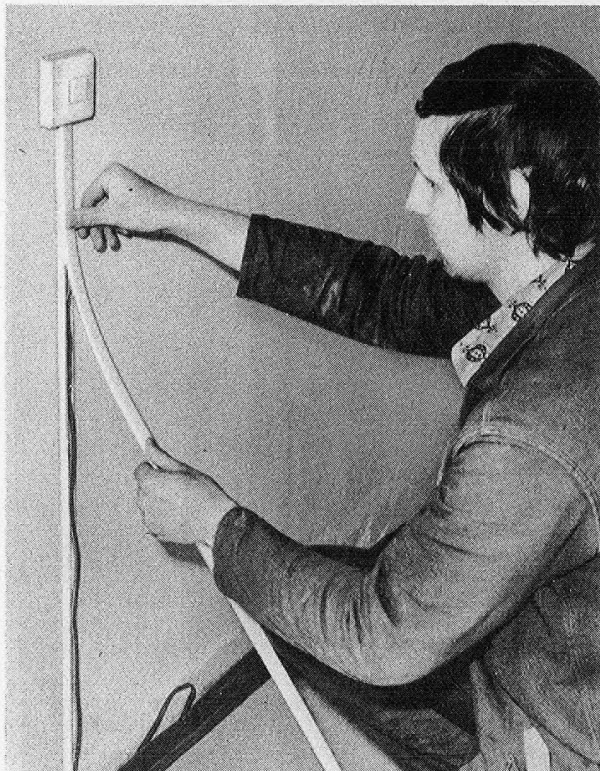
Bild 24 Legen der Leitung in den Wandkanal
