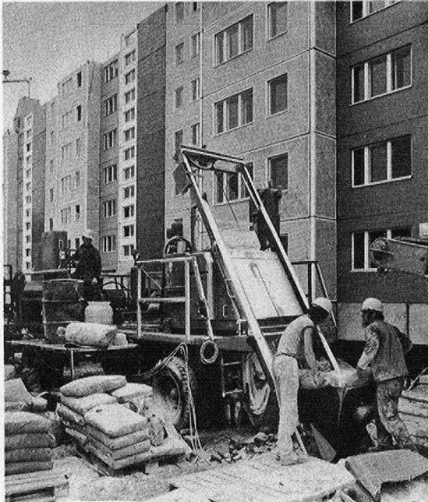
Bild 26 Fahrbarer Misch- und Förderkomplex zur Herstellung von Fließanhydritestrich im WBK Berlin
