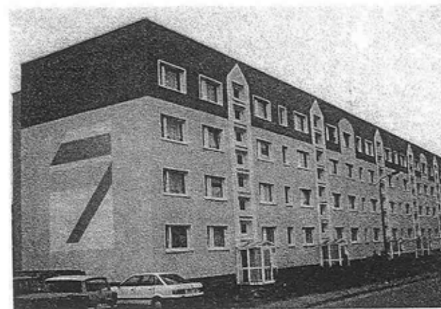
Bild 7.1: Neugestaltung eines modernisierten Wohngebäudes in der Blockbauart 0,8 t, Standort Zehdenick
