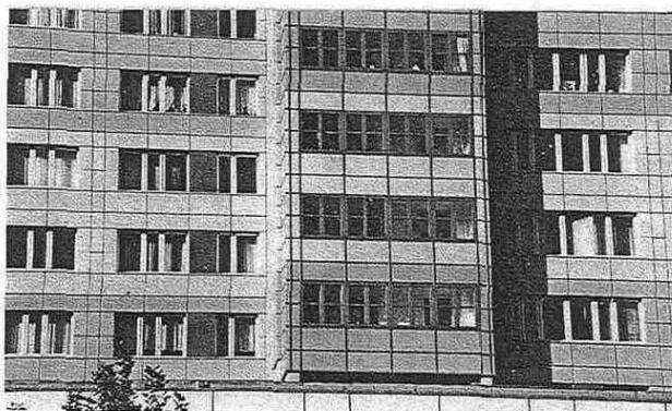
Bild 8.2: Wohnhochhäuser in Berlin, Neugestaltung der Fassaden oben: Loggien unten: Wintergärten
