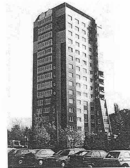
Bild 8.1: Wohnhochhäuser in Potsdam oben: nicht saniert unten: saniert
